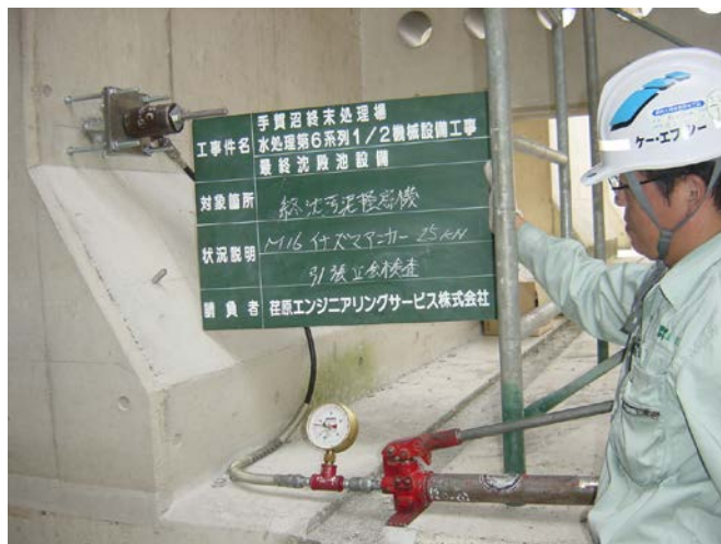
<引抜荷重 25kN 異常なし>
