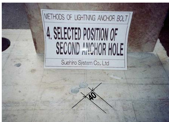
<第2アンカーボルト孔の穿孔>
