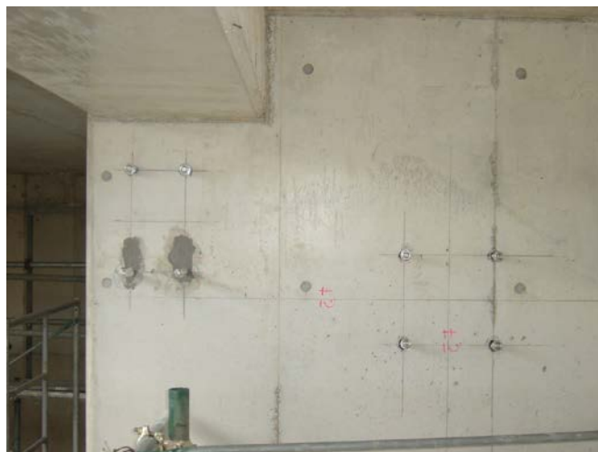
<M16 新型イナズマアンカー施工完了>
