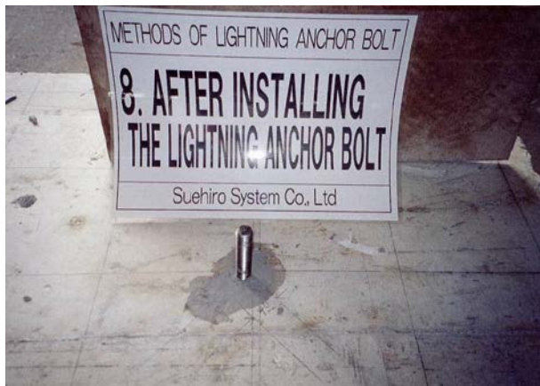
<イナズマアンカーボルト取付完了>
