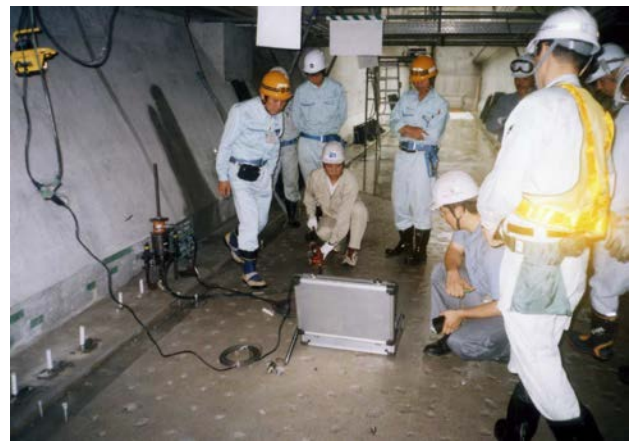
<アンカー引抜試験>
