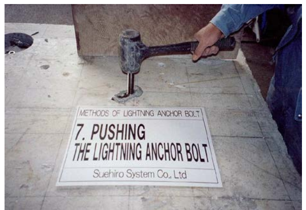
<イナズマアンカーボルト取付>
