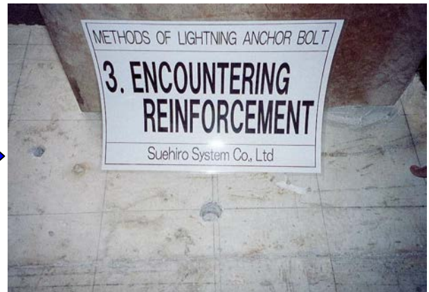
<穿孔位置に鉄筋干渉>
