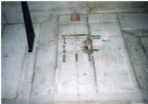
<アンカー打設>
