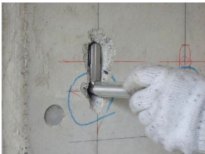
<M16 新型イナズマアンカー仮挿入>
