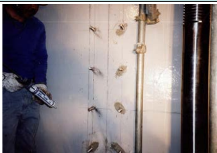
<アンカー打設>
