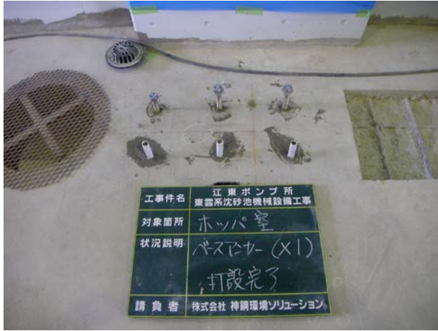
<アンカー打設>
