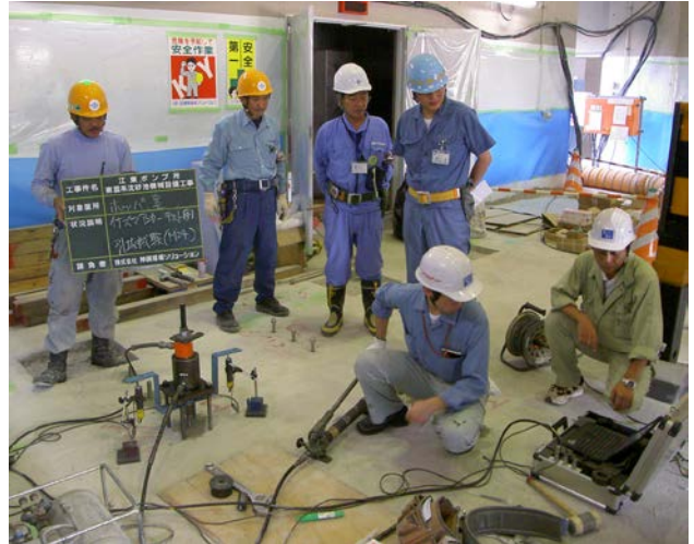
<アンカー引抜試験>
