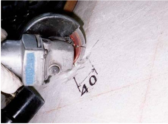
<コンクリート表面をカッター切り>
